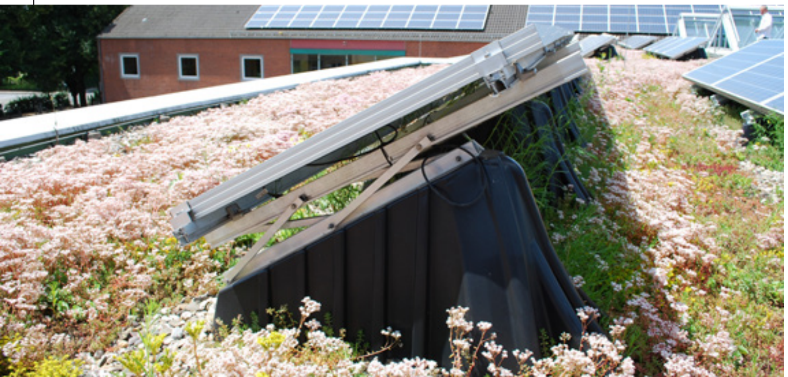
Blick auf das Ausgleichselement „Root Flex“, um die Module variabel verstellen zu können
